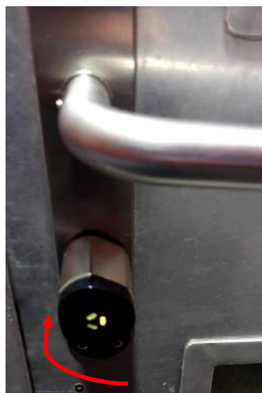
FIGURE 18 – boîtier à code avec bouton « valider » (gauche) | sens pour tourner la serrure une fois le code entré (droite)
